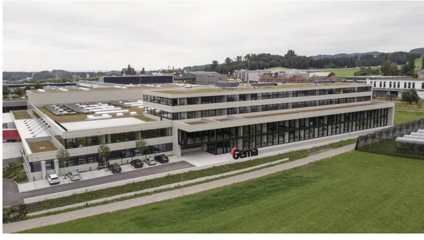
Das neue Firmengebäude auf dem Sommerau-Areal in Gossau.
